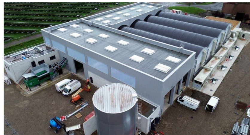
Plateforme de compostage urbain
